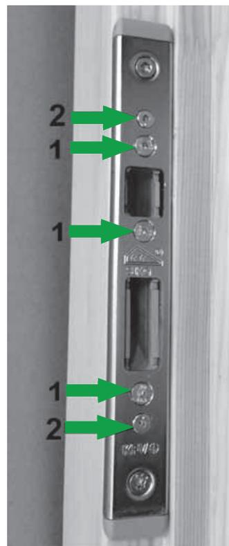
die Schrauben (1) lockern, die Schrauben (2) nach rechts oder links drehen, das Band in die gewünschte Position stellen, die Schrauben sperren (1)
