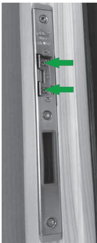
die angezeigten Schrauben lockern, das Band manuell in die gewünschte Position schieben, die Schrauben sperren
